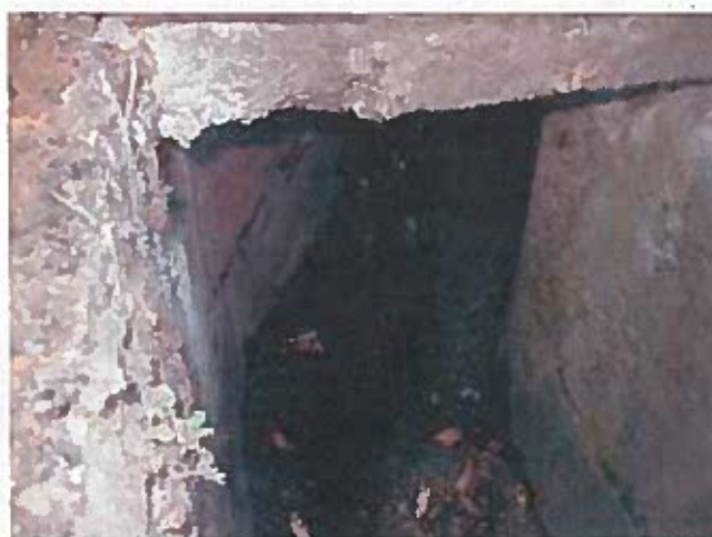
Foto n. 12: particolare della canalizzazione di collegamento tra la caditoia ubicata nello spiazza tra via Baccarini-via De Castro e lo scatolare di via Baccarini – foto scattata dalla caditoia (scatolare largo circa 55 cm per quasi un metro di altezza)
