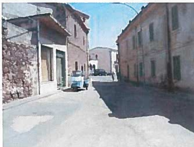
Foto n. 6: vista da via Solferino (biforcazione con via Vittorio Emanuele) del tratto di strada fino a Piazza Unità d'Italia
