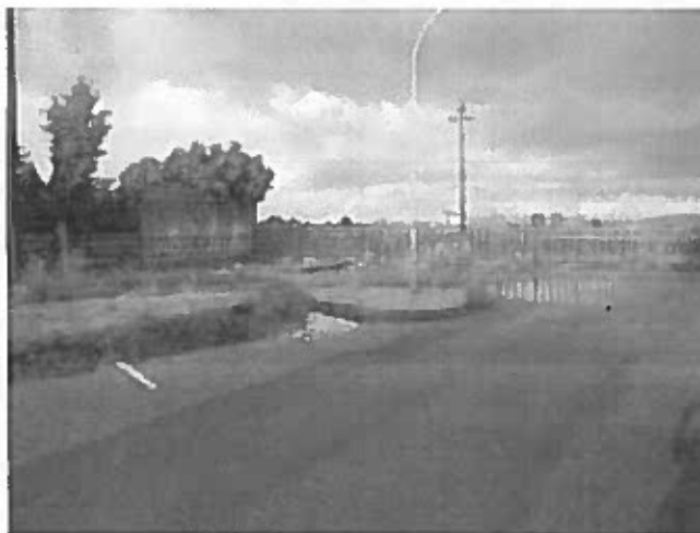
Foto n.7: Evento del 17.06.2015 ore 19.43 l'ista dalla sezione 2 del Tronco critico 'Canalizzazione' (via Dello Sport) dello sbocco della canalizzazione ubicata nel retro della recinzione in cls che delimita la fascia di rispetto della linea ferroviaria - evento terminato da 20-25 minuti
