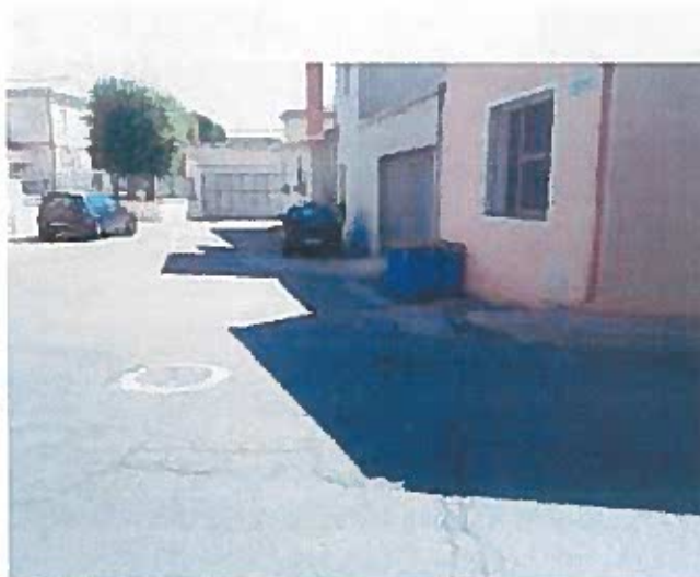
Foto n. 3: vista da via Baccarini della via Minghetti, in corrispondenza dei contenitori blu è ubicata la caditoia che convoglia le acque di via Minghetti verso lo scatolare di via Baccarini
