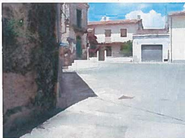
Foto n. 2: vista del tratto di monte di via Baccharini in corrispondenza dell'intersezione con la via Roma e a sinistra con la via Solferino (si noti in primo piano l'accumulo di materiale trasportato dalle acque che a ridosso del muro dell'edificio in primo piano sulla sinistra si accumulano)
