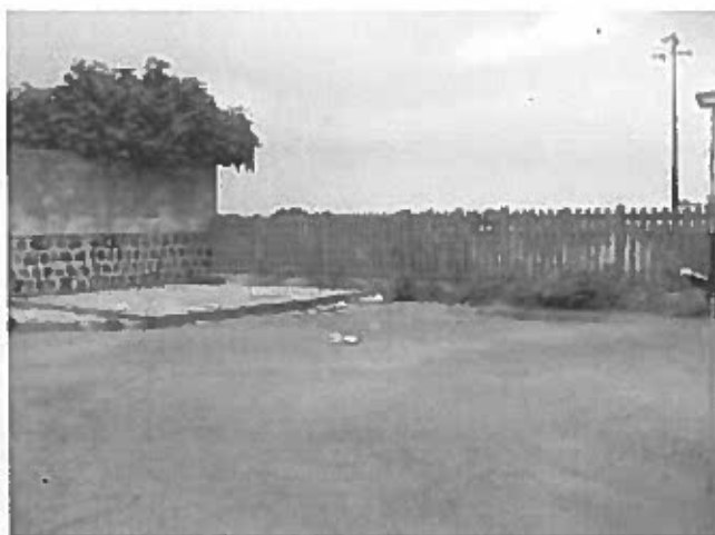
Foto n. 20: via Dello Sport, piazzale antistante il campo sportivo comunale, in primo piano la recinzione di delimitazione della fascia di rispetto della linea ferroviaria Cagliari-Sassari-Golfo Aranci, oltre la recinzione è ubicato lo sbocco della canalizzazione di via Baccarini-via Dello Sport
