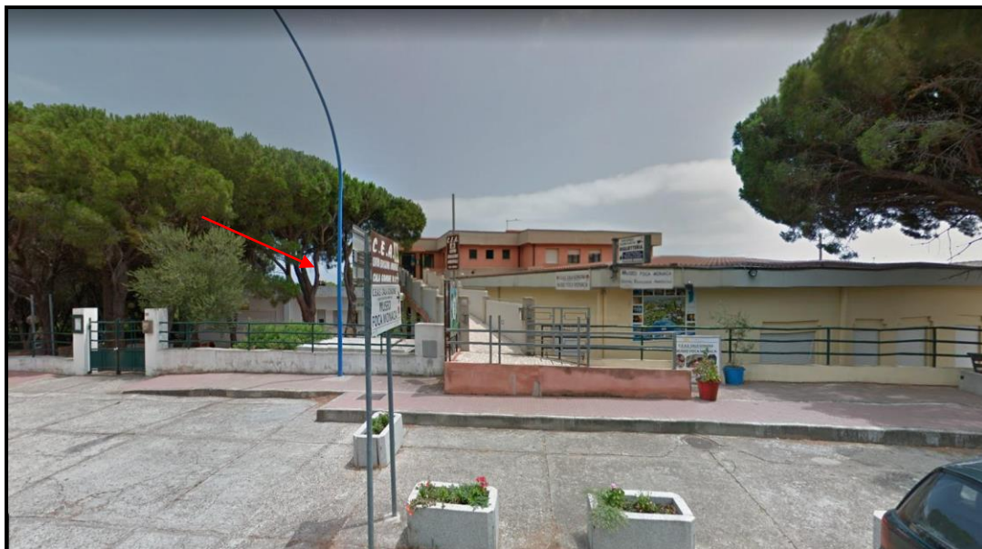
Vista da viale Bue Marino della rampa di accesso al CEA collocato a destra, sulla sinistra è visibile il lastrico da sopraelevare
