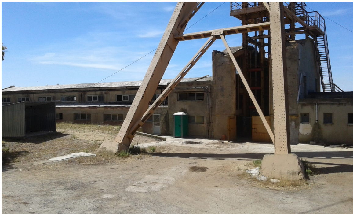
Figura 6 – Prospetto frontale con accesso ricetta pozzo 1
