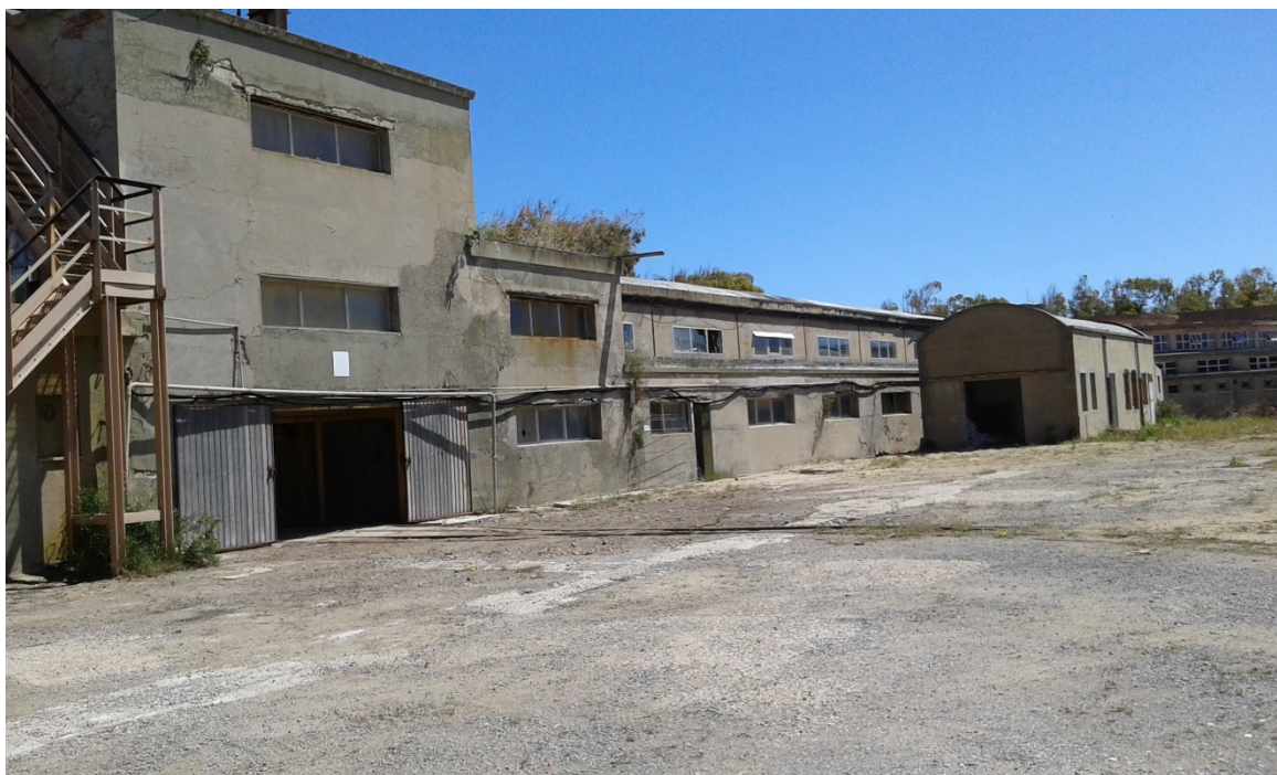
Figura 4 – Prospetto posteriore con immobile attiguo da demolire parzialmente
