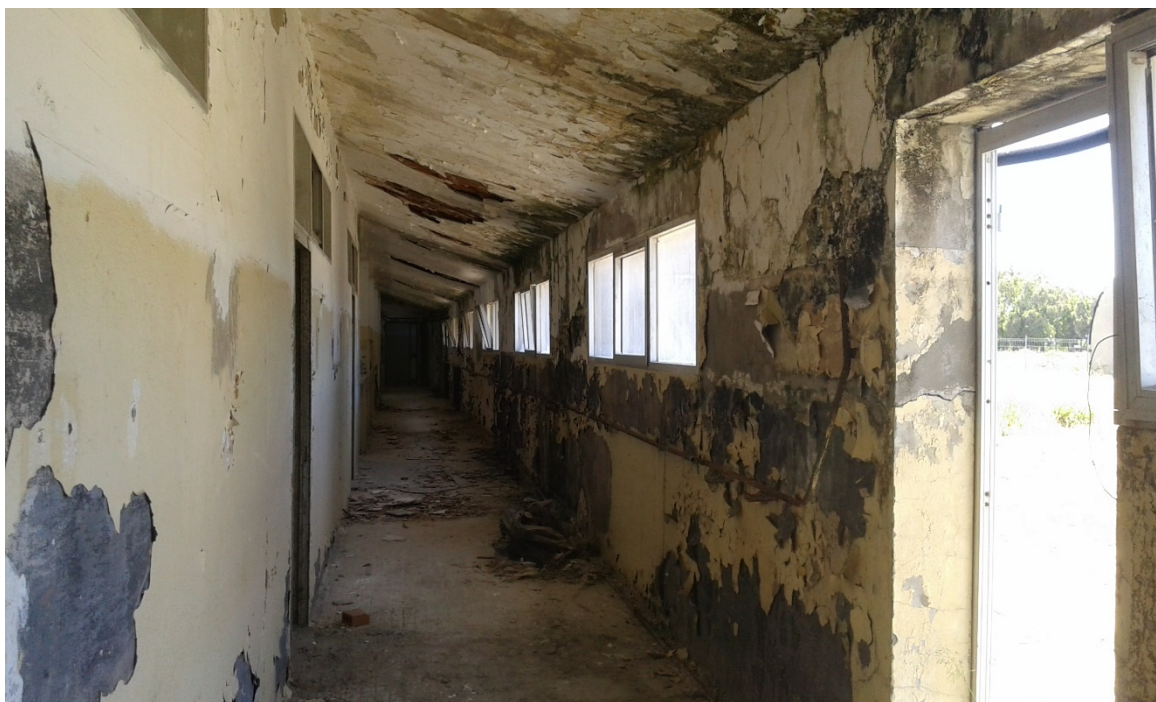
Figura 7 – Vista interna corridoio laterale
