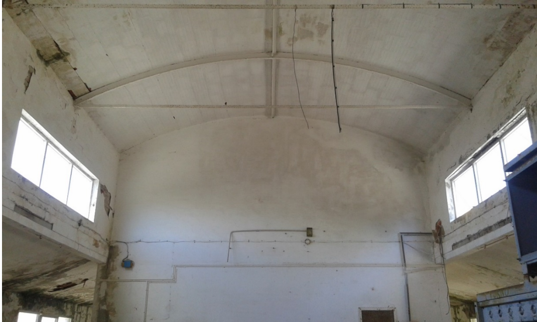
Figura 8 – Vista interna solaio a botte
