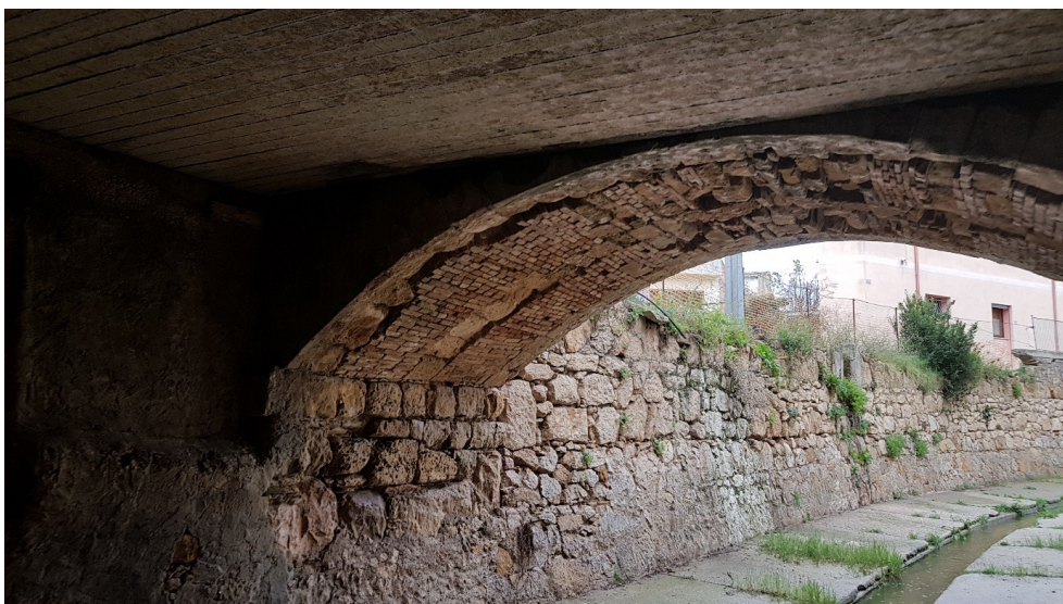
Foto 6 – sezione con arco murario ponte pedonale
