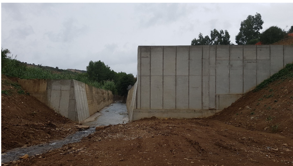
Foto 8 – briglia selettiva – inizio del tratto canalizzato urbano del Rio Pau.
