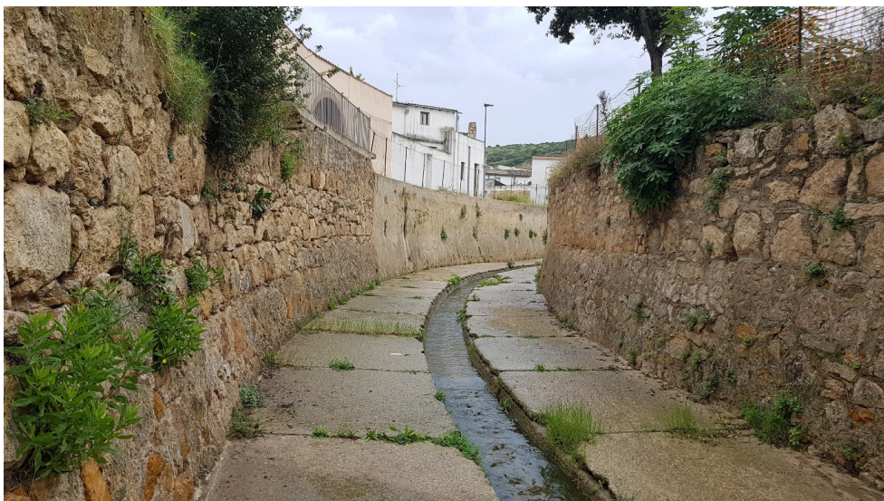
Foto 7 – tratto di intervento "D" – canale a monte di Piazza Repubblica.
