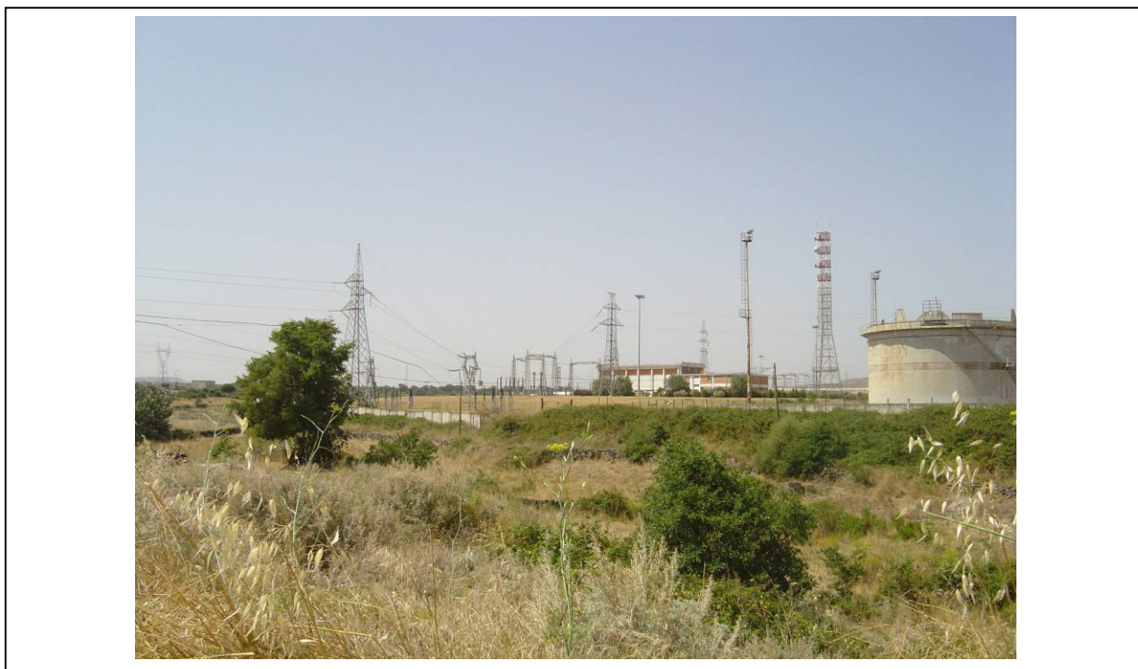
Figura 20 - Vista verso S dell'alveo del Rio de Corte; sulla destra, la stazione elettrica
