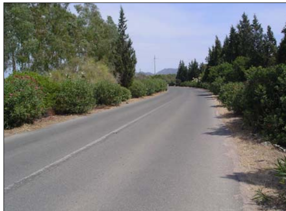
Figura 3.2-6: Strada comunale che permette di raggiungere Is Molas
