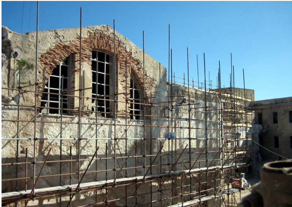
2. Un cantiere di recupero nel centro storico di Alghero.
