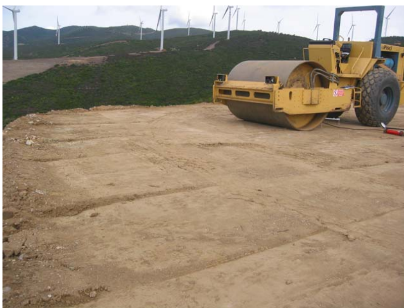
Figura 3 – Una delle piazzole dell'impianto eolico di Villaurbana (OR) , in corso di realizzazione; dimensioni e caratteristiche costruttive sono sostanzialmente equivalenti a quelle delle piazzole dell'impianto di Fiume Santo
