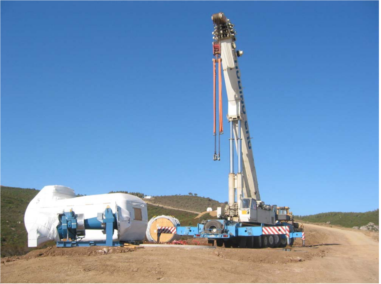
Figura 5 – Particolare della piazzola
