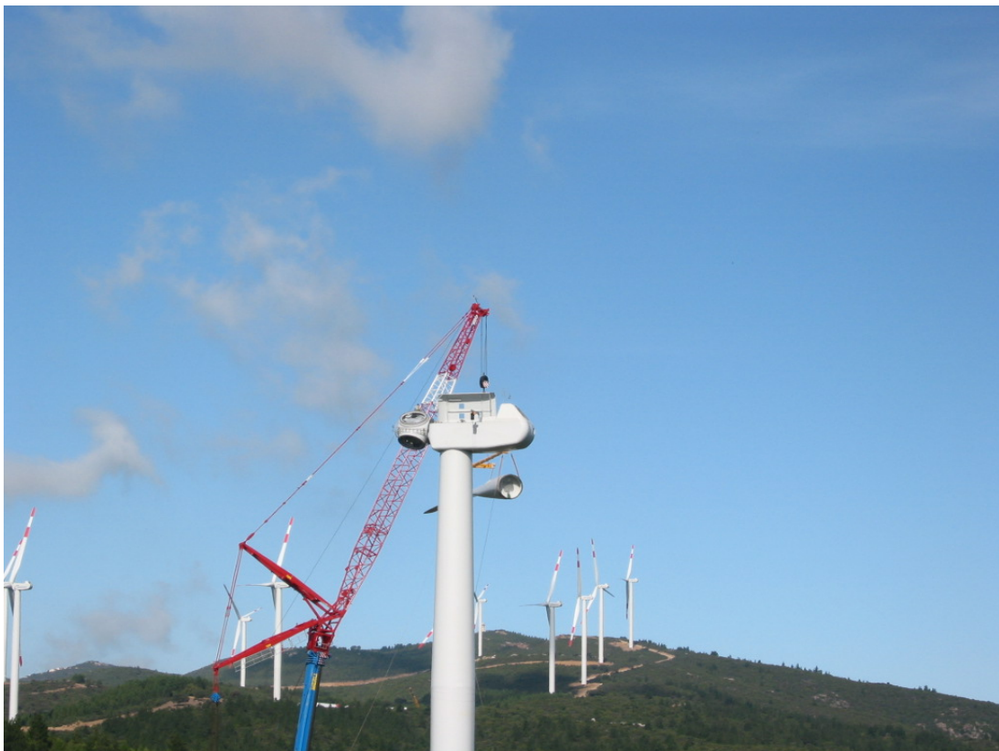
Figura 2 - Posa in opera degli aerogeneratori
