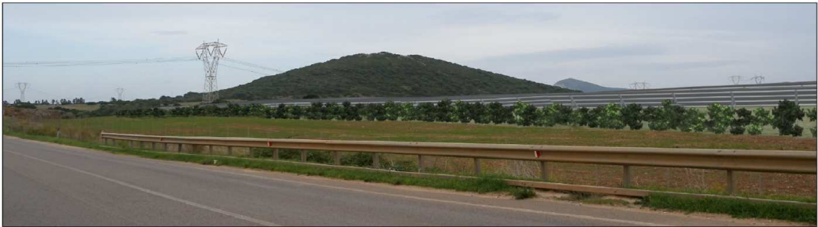
Figura 45 - Punto di scatto 2- vista a
