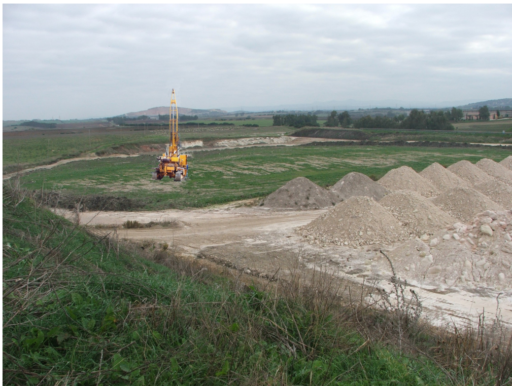
Foto n° 3 : Simulazione dell'intervento durante le attività di perforazione
