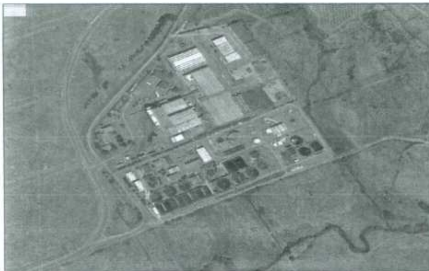
Figura 2: dettaglio aereo dell'installazione
