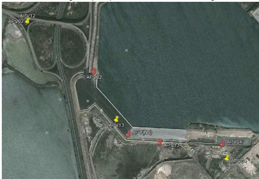
Ortofotogramma riportante l'ubicazione dei punti di misura (puntatore rosso postazione di misura impiegate, puntatore giallo postazioni di misura previste). Immagine estratta dalla Relazione sul Monitoraggio in Corso d'Opera del I Trimestre relativa ai "Lavori di completamento del banchinamento del lato sud del bacino di evoluzione del Porto Canale"
