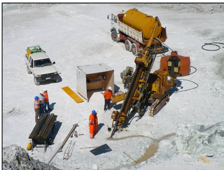
Figura 9.8: Esecuzione di sondaggi di approfondimento mirati alla definizione delle caratteristiche geomeccaniche (2009)
