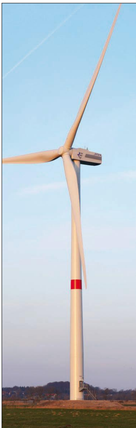
Figura 8 – Aerogeneratore REpower 3.2M123
