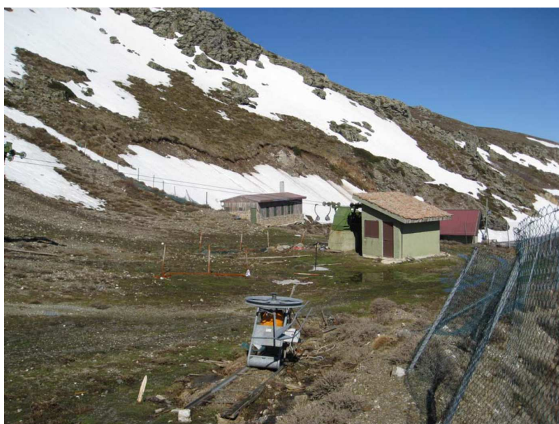
Figura 4 – stato attuale della stazione di partenza dell'impianto di risalita
