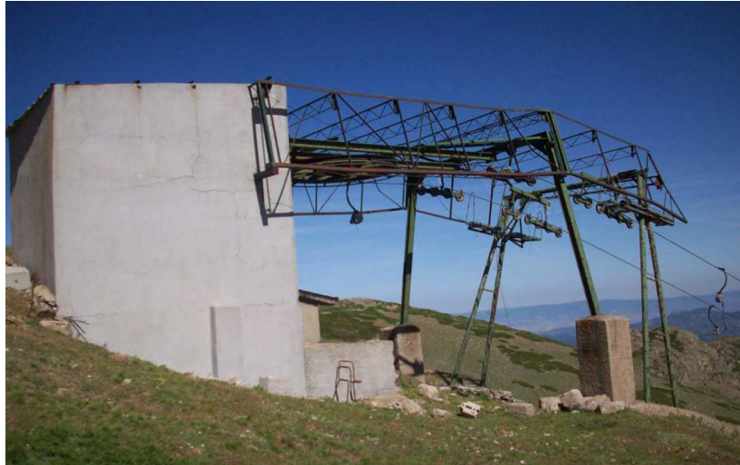
Figura 5 – stato attuale della stazione di arrivo dell'impianto di risalita
