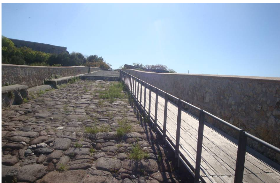
Foto 8.2.1/c - Porto Torres: Particolare del Ponte Romano
