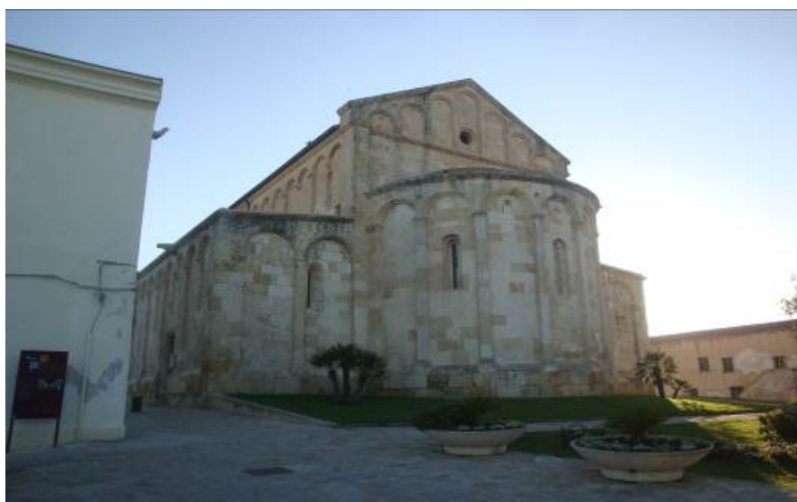
Foto 8.2.1/d - Porto Torres: Basilica romanica di San Gavino
