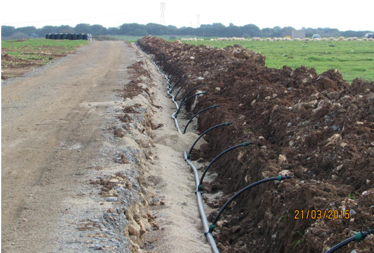
Figura 3: vista su viabilità interna, visibile il cassonetto in pietre
