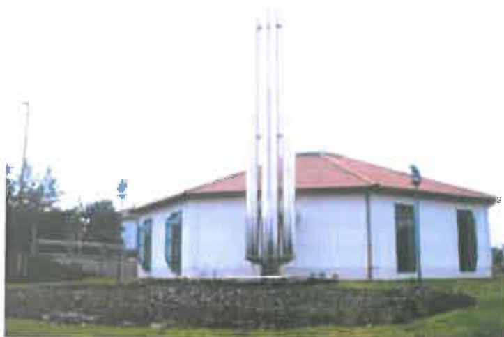
Fig. 3 - Esempio di centrale geotermica a media entalpia da 2 MWh (Straubin, Germania)
