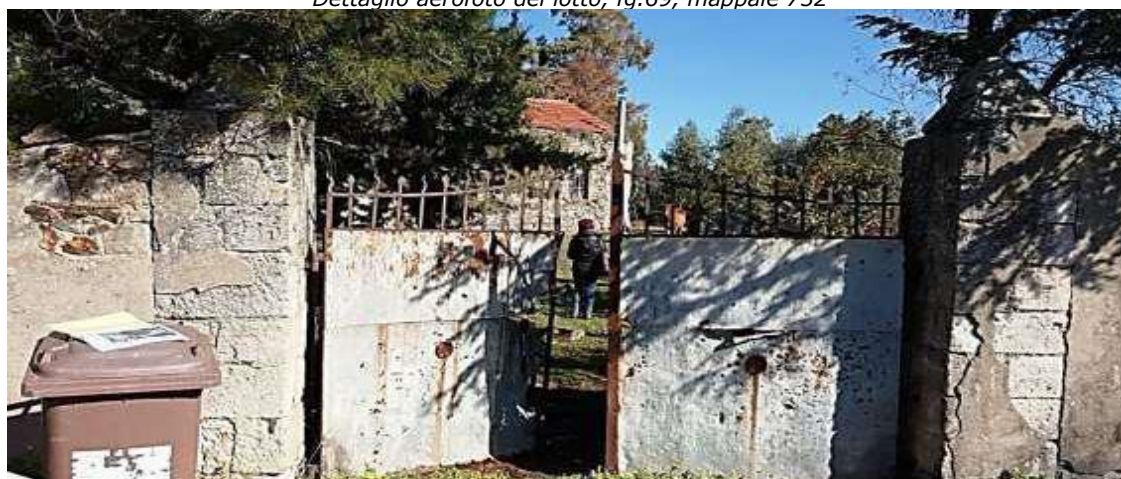
Dettaglio ingresso ai beni, fg.69, mappale 732
