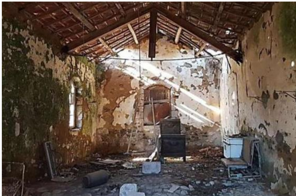
Vista interna con dettaglio sulla capriata di parte della copertura.
