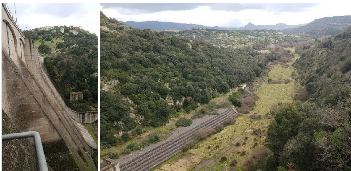
Figura 9 – Vista del paramento e dell'alveo a valle
