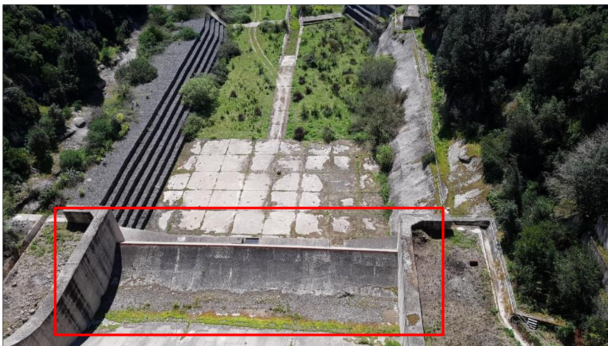
Figura 14 – Vasca di dissipazione dello scarico di superficie
