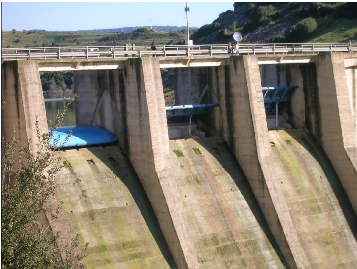
Figura 10 – Diga dell'Alto Temo . Vista delle ventole dello scarico di superficie
