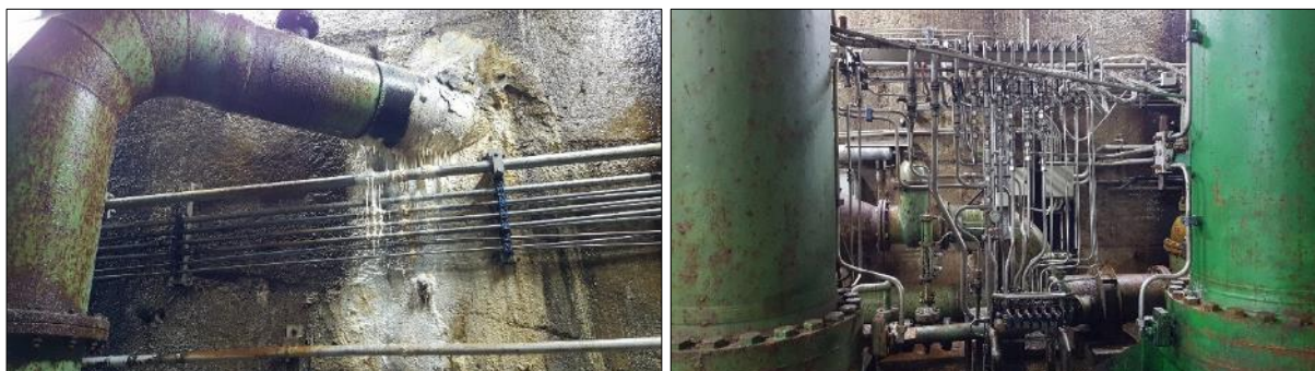
Figura 25 - Pozzo dello scarico di fondo – Pistoni delle paratoie dello scarico di fondo
