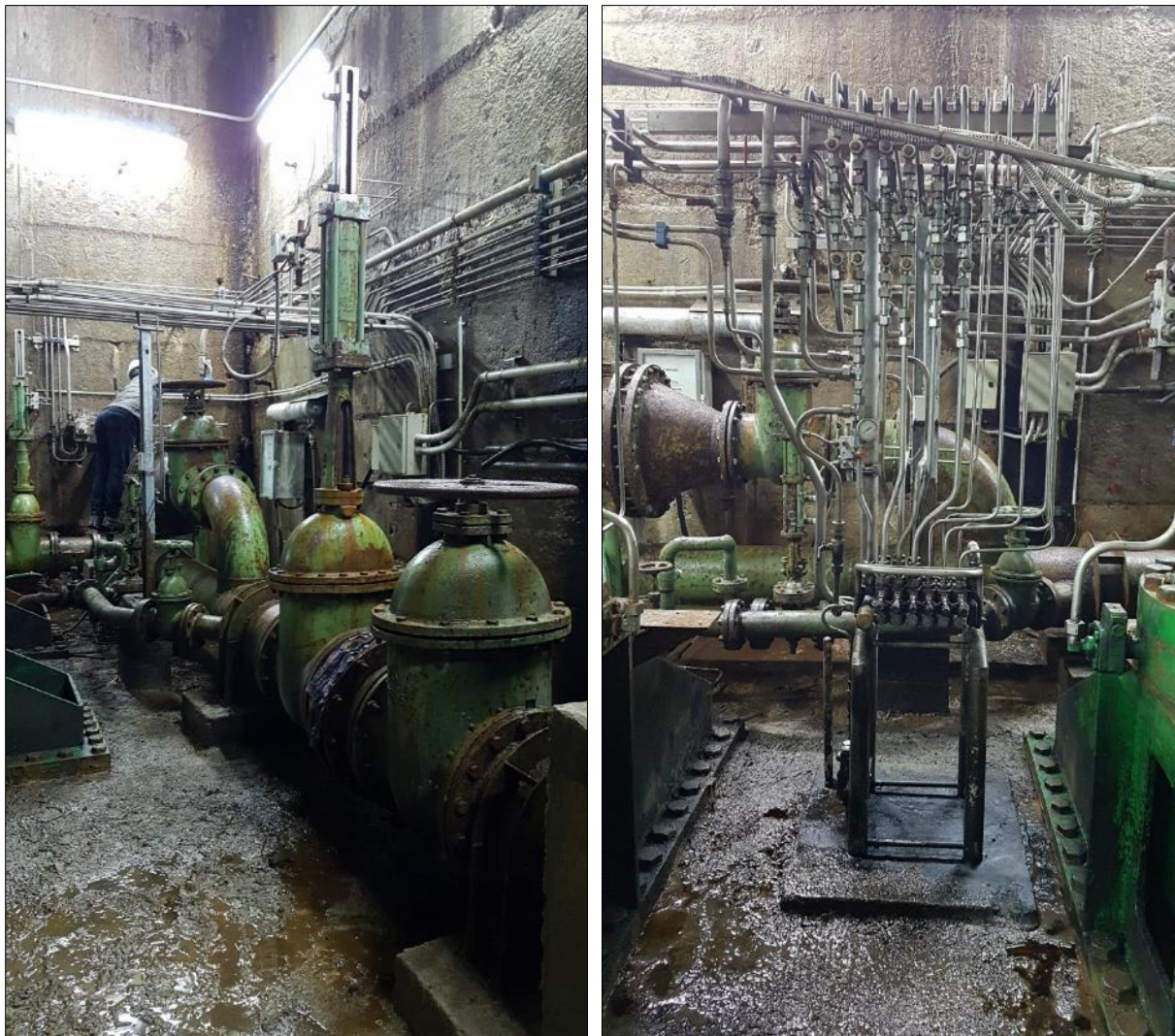
Figura 26 – Pozzo dello scarico di fondo – Condotta di derivazione e distributore oleodinamico
