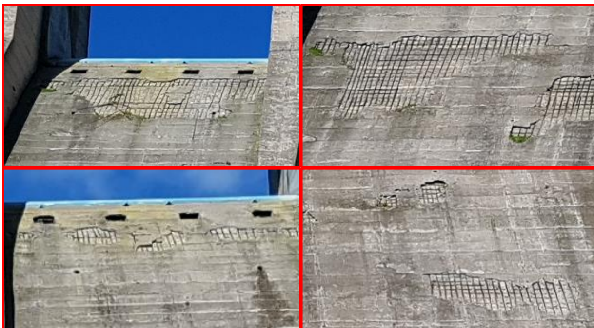
Figura 13 – Scivolo dello scarico di superficie: vista di alcune porzioni con distacco del copriferro
