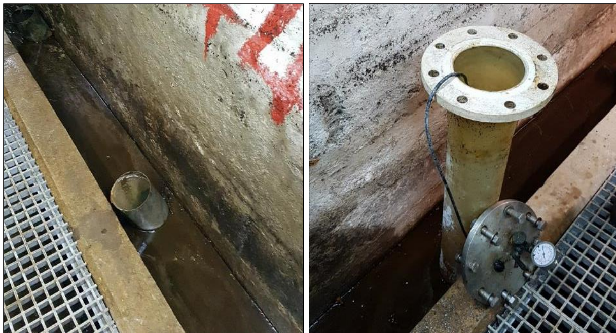
Figura 28 – Fori di drenaggio (sinistra) e piezometri (destra)
