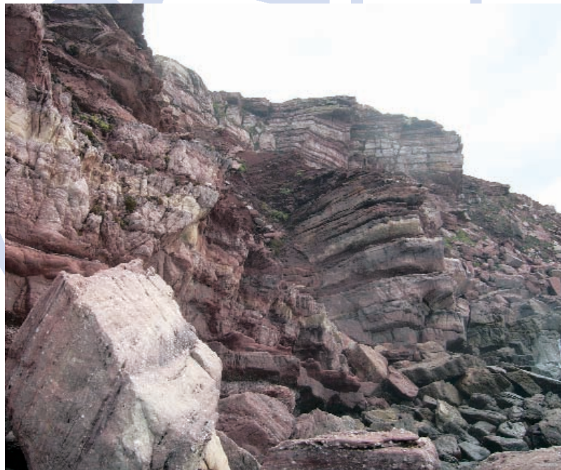
Area a crolli e ribaltamenti diffusi poco ad Est di Torre del Porticciolo (Alghero) su complesso sedimentario permo-triassico.
