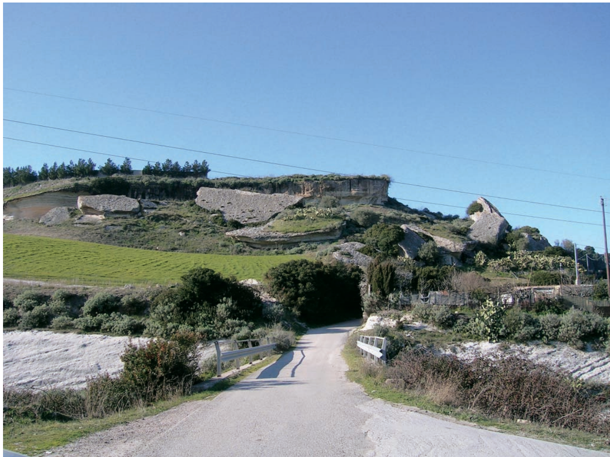
Figura 16: Comune di Ploaghe (SS) Aree con fenomeni di crolli e ribaltamenti diffusi su litologie calcarenitiche.
