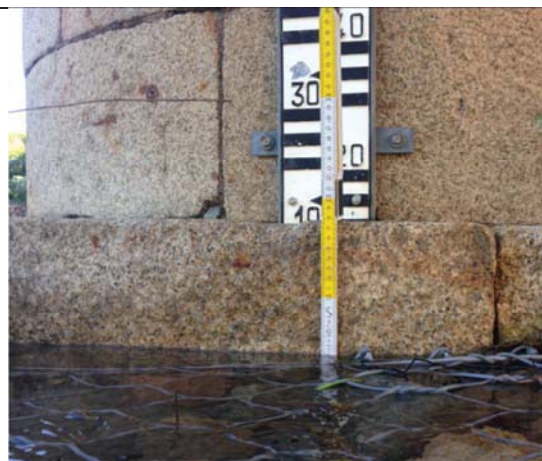
Particolare asta idrometrica e mantellata alveo
