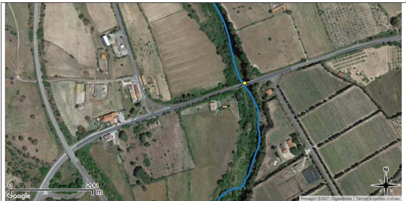
Foto Satellitare: Fiume Tirso in stazione "Tirso a distributore Tirso" su Ponte S.S. 129 TRASVERSALE SARDA (ILLORAI).
