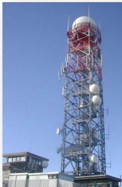
Installazione a Monte Rasu
