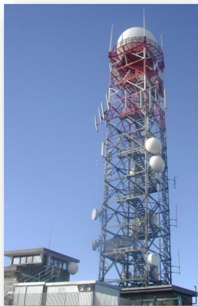
Installazione a Monte Rasu
