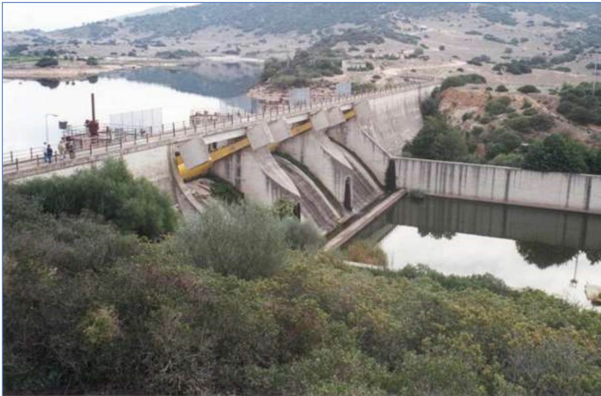
Figura 1 – Diga di Benzone, vista da valle in sponda destra
