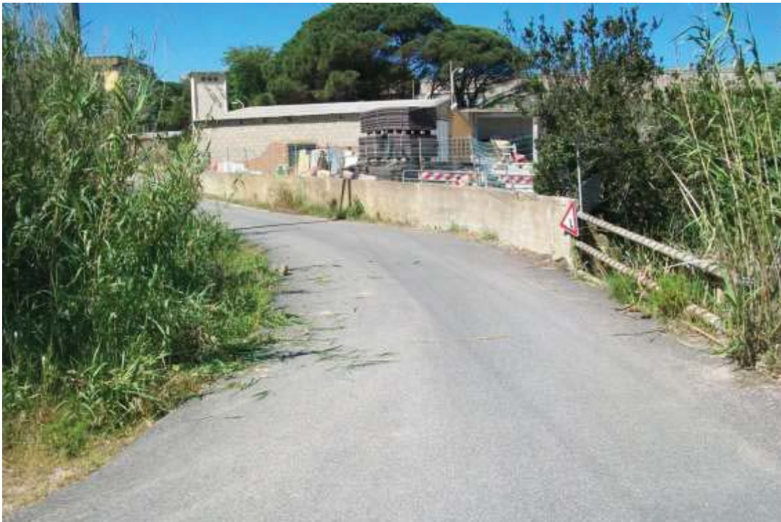
Figura 5 - Ponte ID_45 su strada comunale
