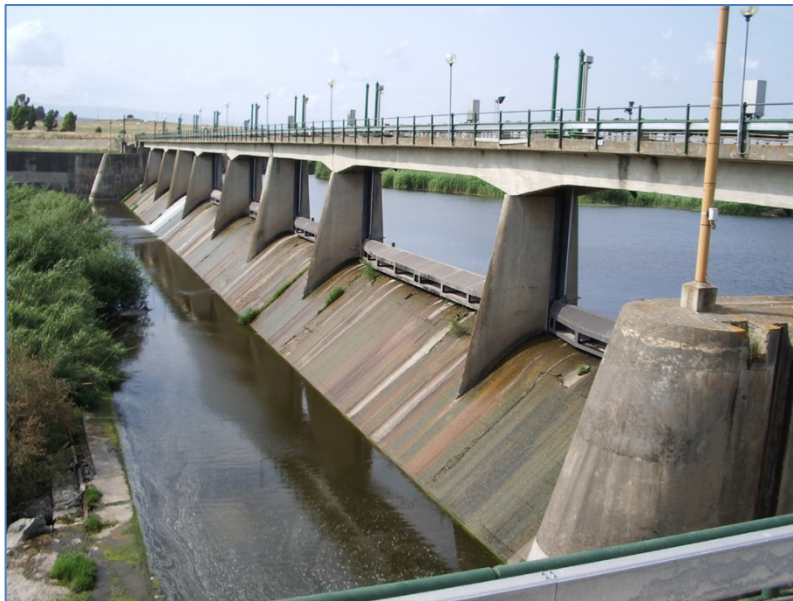
Figura 1 – Diga di Santa Vittoria, vista da sponda sinistra di valle
