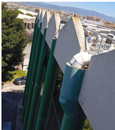
Facciata con carter per passaggio future colonne
