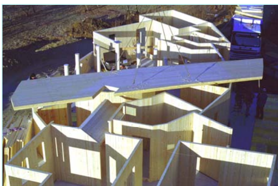
Figura 1: esempio di edificio a pannelli in legno lamellare incrociato in costruzione in Trentino
