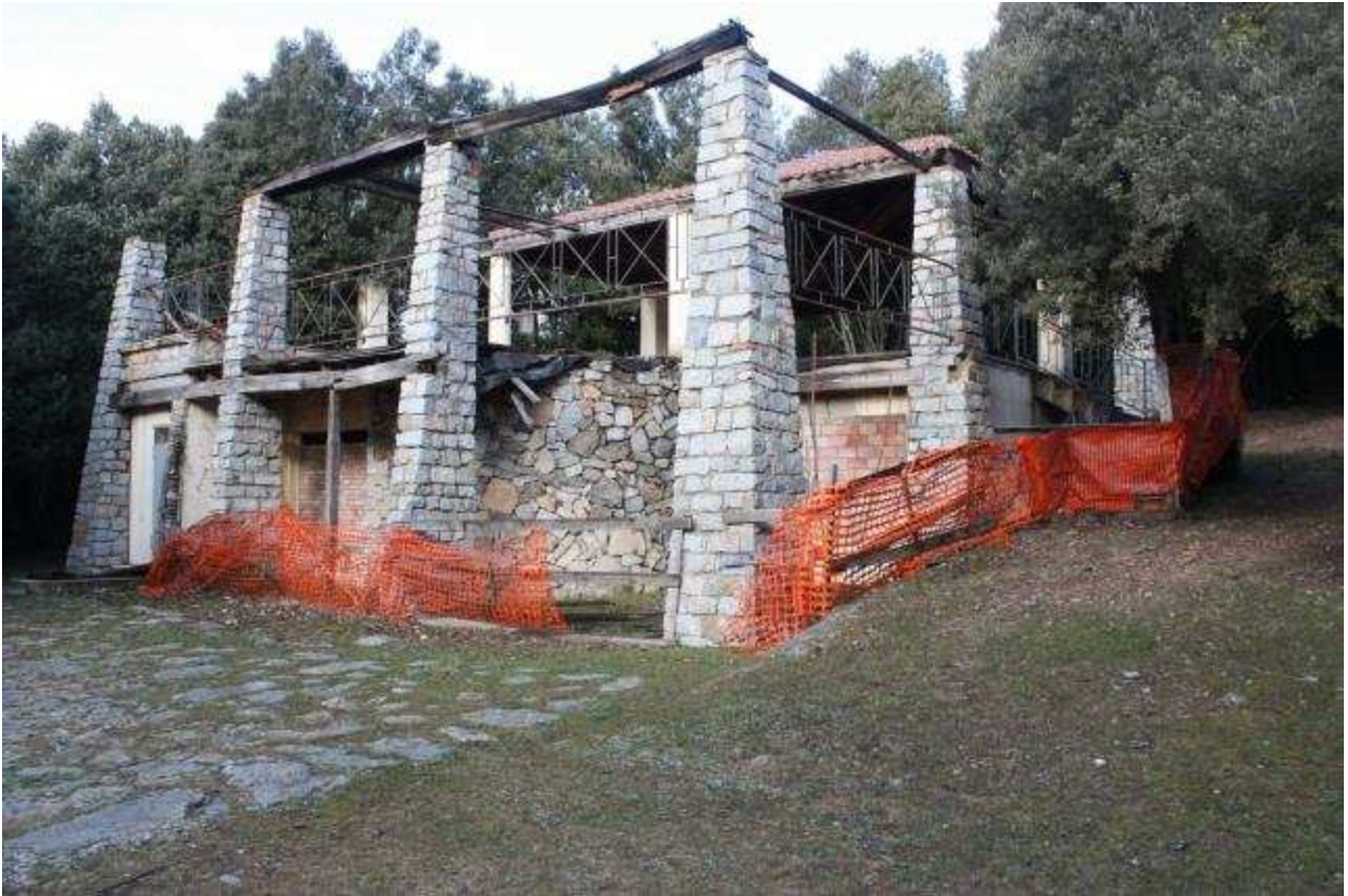
Selèni (c.f. San Cosimo). Locali di servizio adiacenti la chiesa dei SS. Cosma e Damiano
