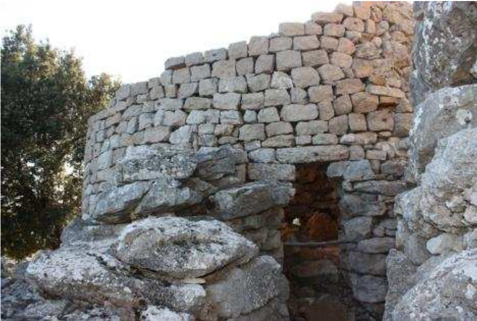
Serbissi (c.f. Taccu) . Torre C dopo il restauro
