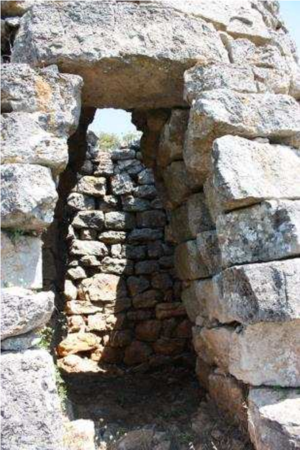
Urceni (c.f. Taccu ). Particolare ingresso torre principale
