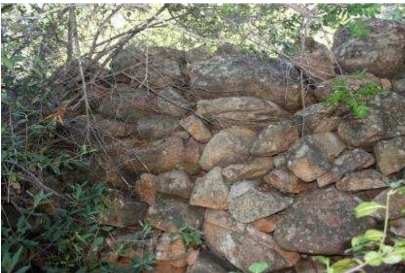
Coccorròci (c.f. Monte Ferru). Strada romana. Muro di contenimento
