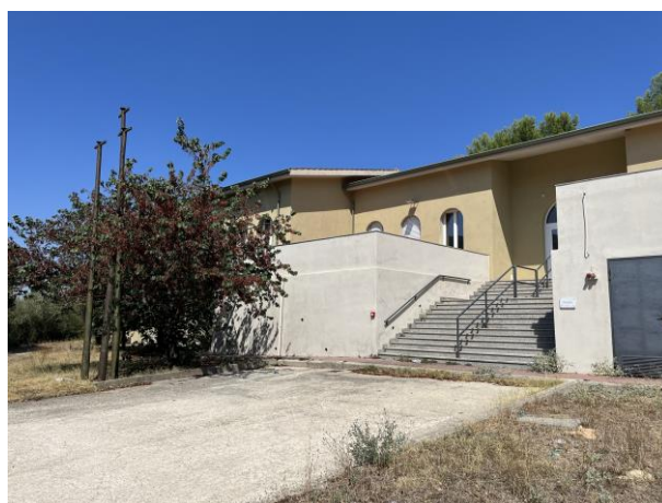
4. Prospetto sud, vista dell'ala su cui intervenire
