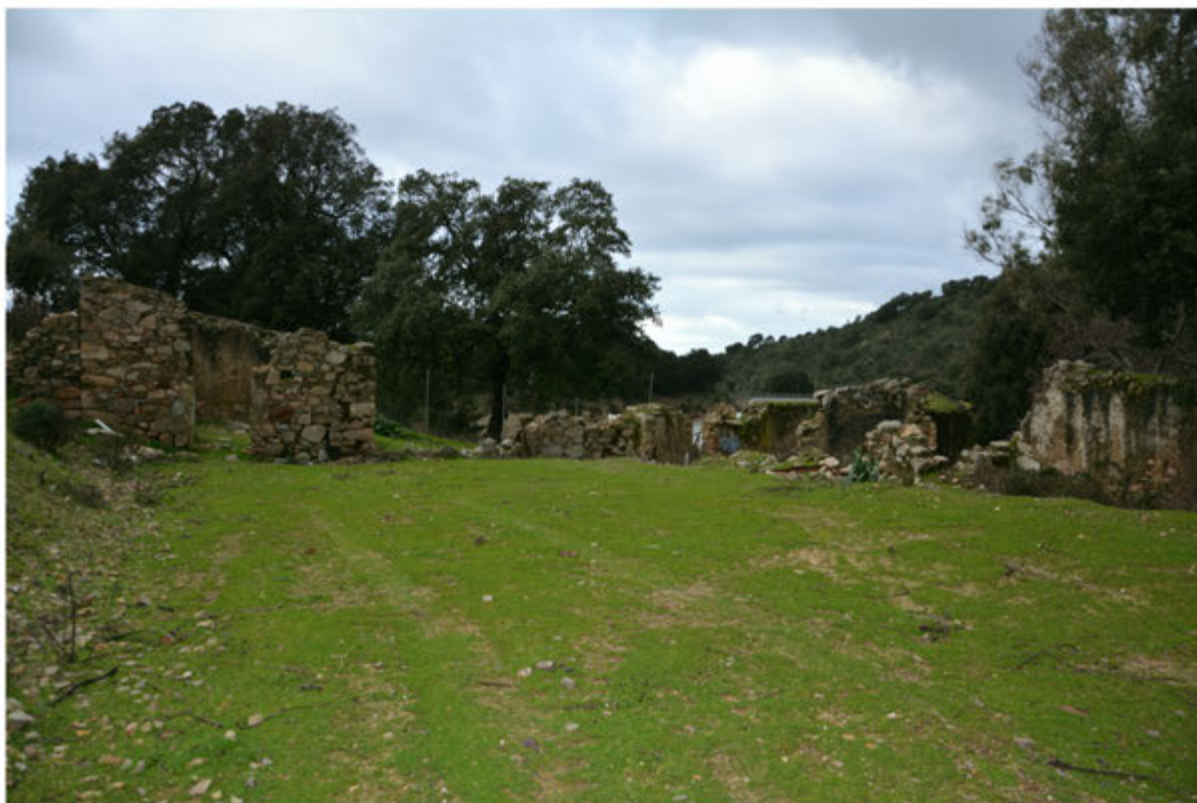
Foto 1: Edificio 1 - Foglio 510 mapp.126
