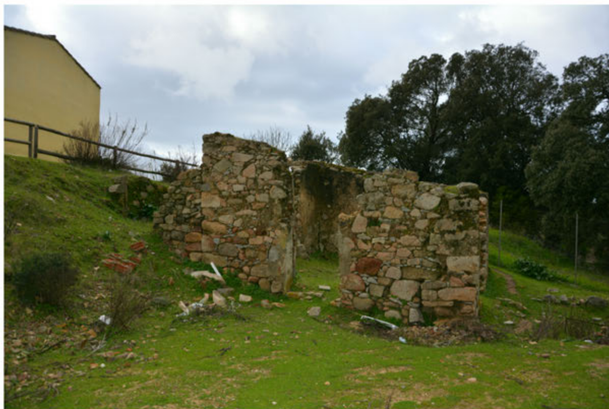
Foto 2: Edificio 1 - Foglio 510 mapp.126
