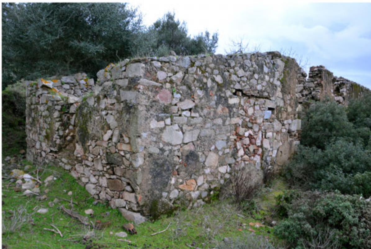
Foto 19: Edificio 5 - Foglio 511 mapp.2
