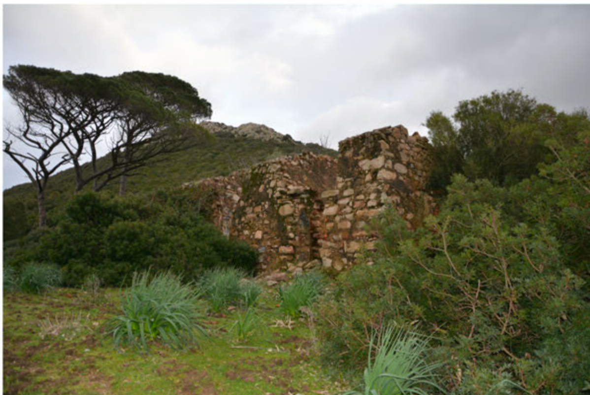
Foto 17: Edificio 5 - Foglio 511 mapp.2
