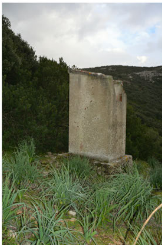
Foto 16: Edificio 4 - Foglio 509 mapp.91
