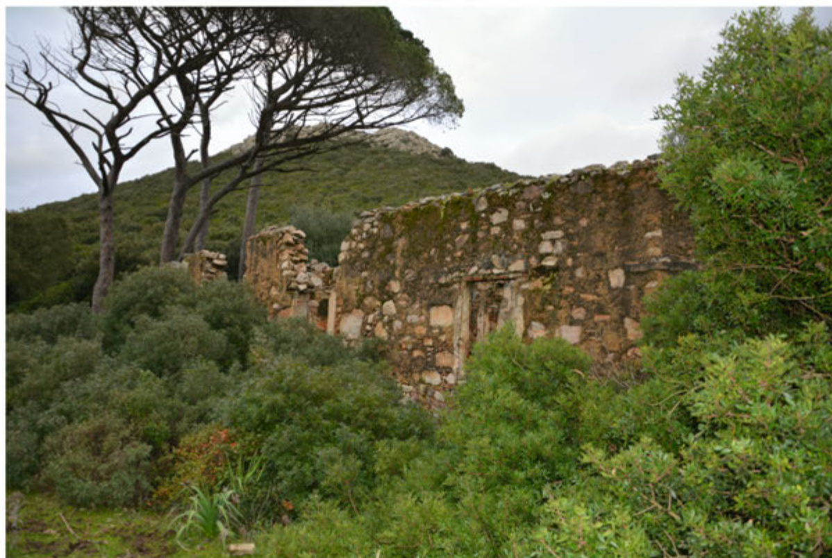
Foto 18: Edificio 5 - Foglio 511 mapp.2
