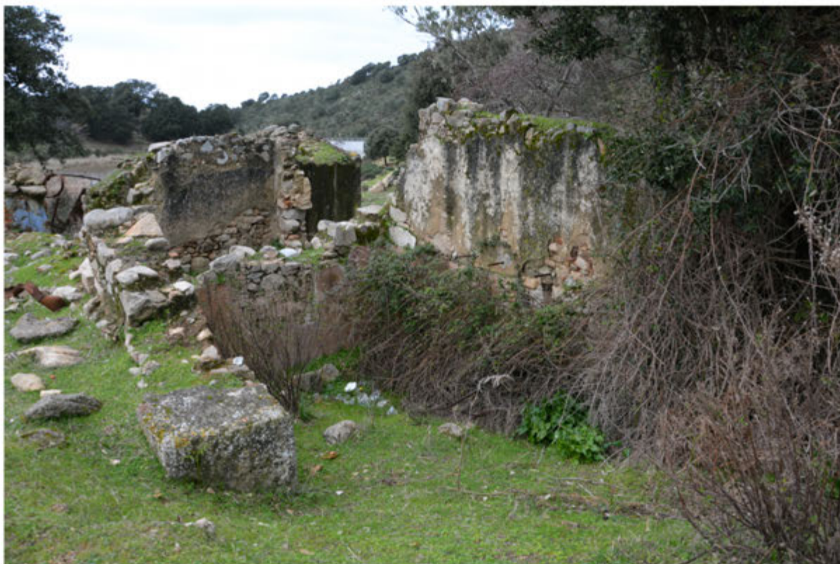
Foto 3: Edificio 1 - Foglio 510 mapp.126
