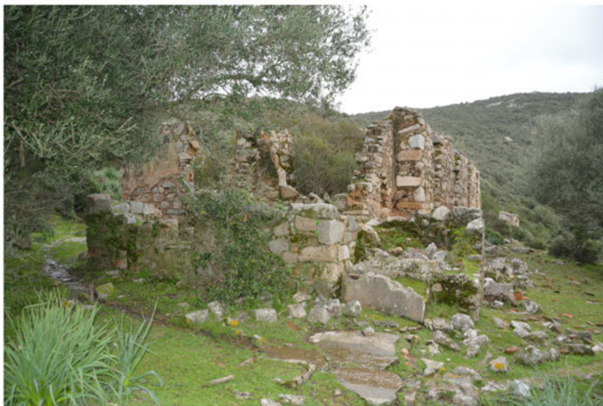
Foto 14: Edificio 4 - Foglio 509 mapp.91
