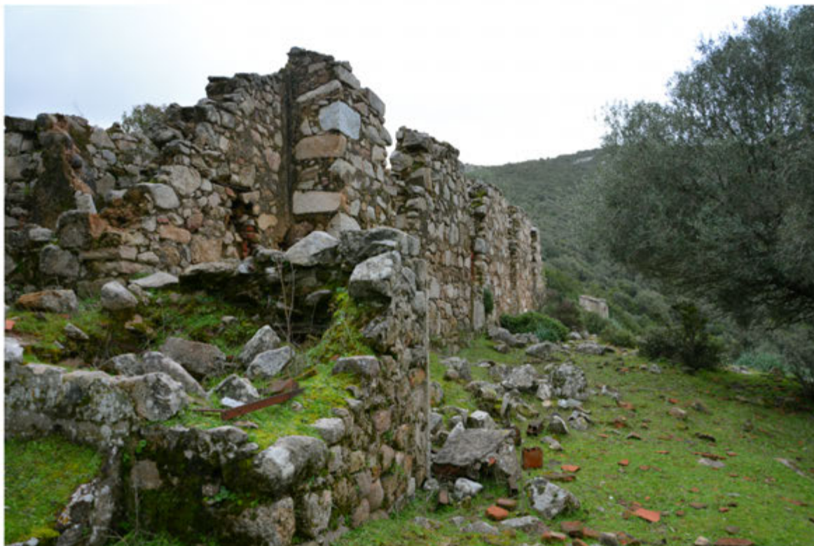
Foto 15: Edificio 4 - Foglio 509 mapp.91
