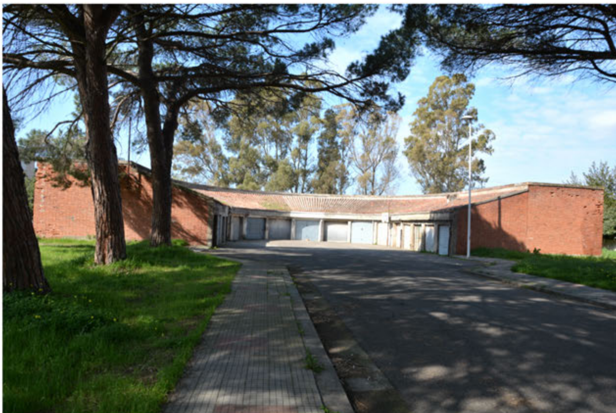
Foto 45: Unità immobiliare 7 - Vista d'insieme del fabbricato - Foglio 29 mapp.298
