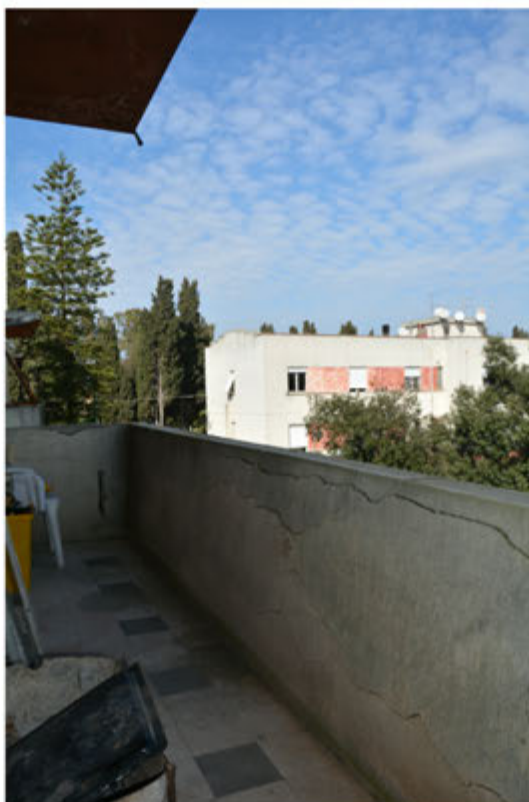
Foto 22: Unità immobiliare 1 - Balcone- Foglio 37 mapp.1973 sub.3
