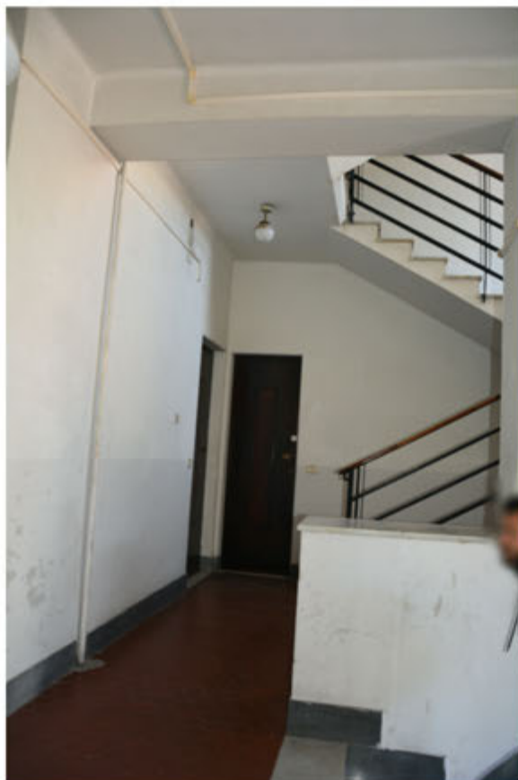
Foto 29: Unità immobiliare 3 - Scala interna condominiale - Foglio 37 mapp.1973 sub.6
