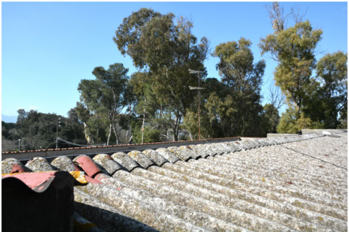
Foto 34: Unità immobiliare 3 - Copertura - Foglio 37 mapp.1973 sub.6
