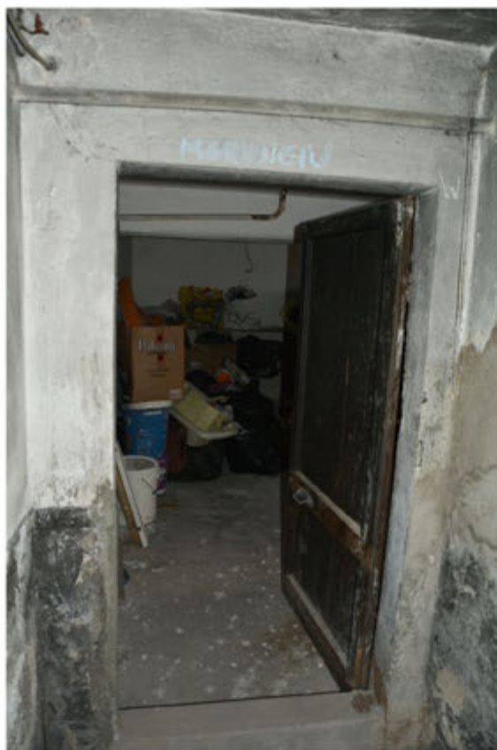
Foto 23: Unità immobiliare 2 - Porta d'ingresso alla cantina- Foglio 37 mapp.1973 sub.10
