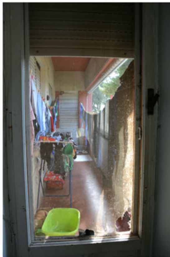
Foto 42: Unità immobiliare 3 - Balcone - Foglio 37 mapp.1973 sub.6
