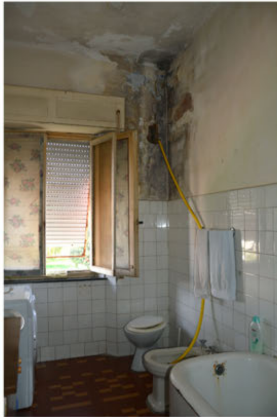
Foto 15: Unità immobiliare 1 - Bagno - Foglio 37 mapp.1973 sub.3
