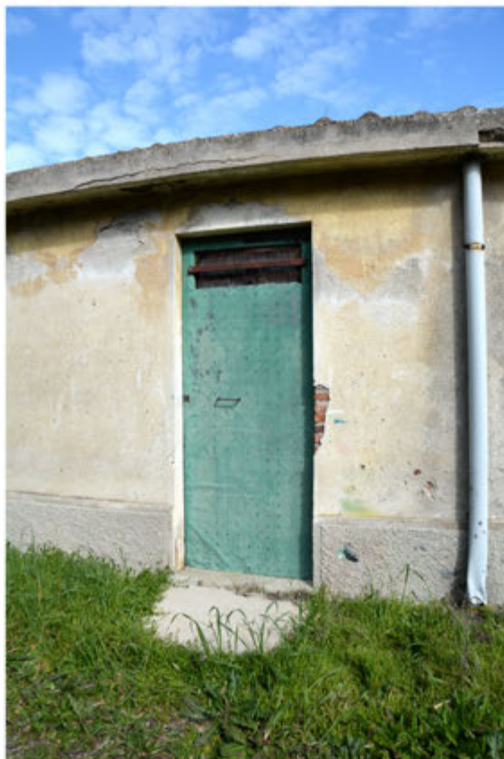
Foto 47: Unità immobiliare 7 - Porta d'ingresso alla cantina - Foglio 29 mapp.298 sub.7
