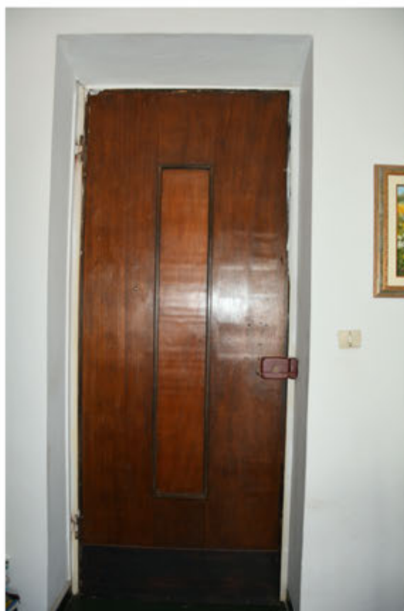
Foto 35: Unità immobiliare3 - Portoncino d'ingresso all'appartamento - Foglio 37 mapp.1973 sub.6
