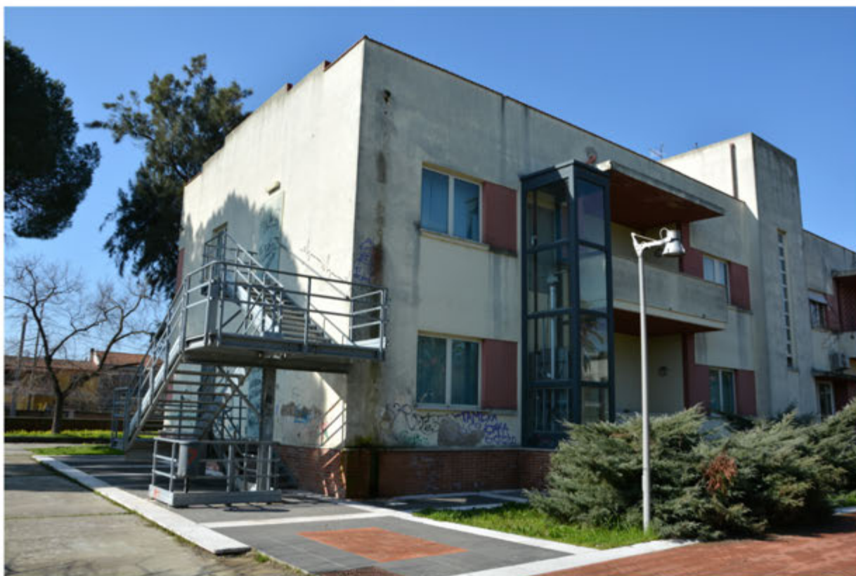
Foto 7: Unità immobiliare 1 - 7 - Vista scala antincendio e ascensore - Foglio 37 mapp.1973
