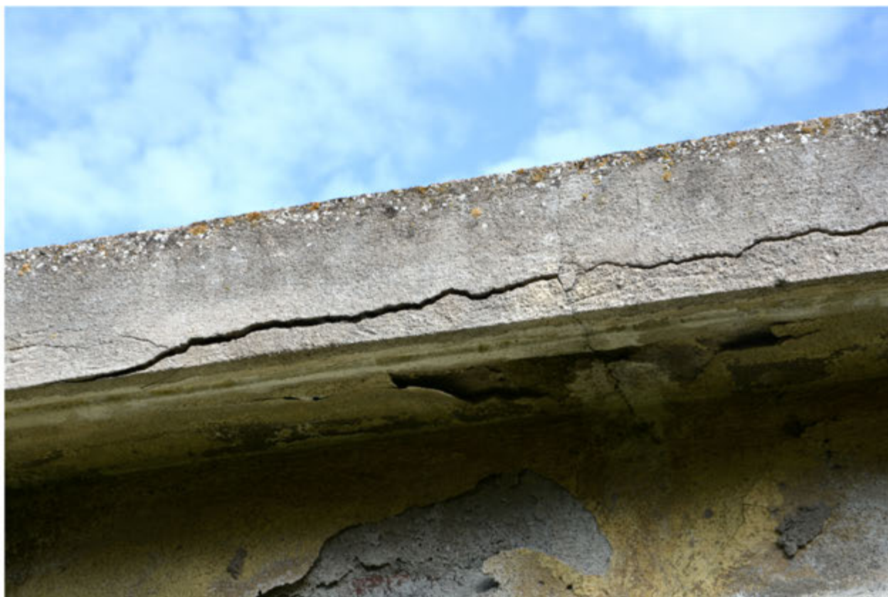
Foto 48: Unità immobiliare 7 - Dettaglio cordolo - Foglio 29 mapp.298 sub.7
