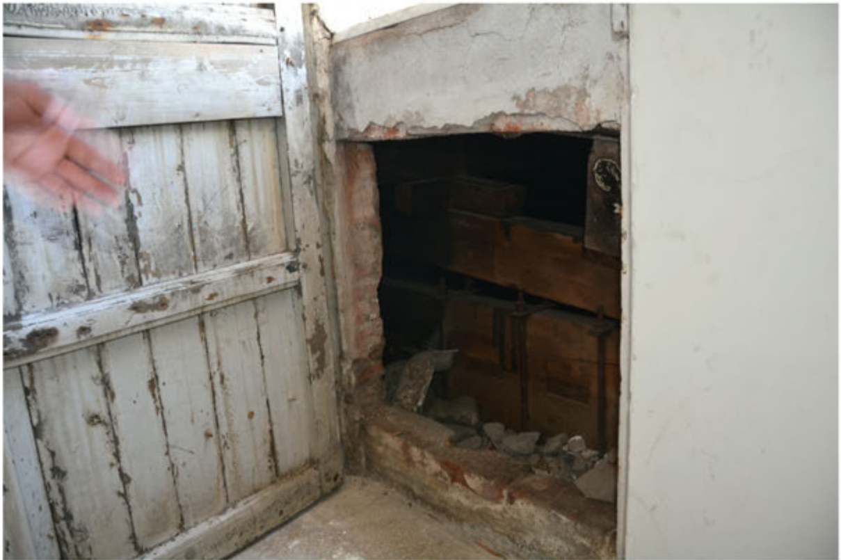
Foto 33: Unità immobiliare 3 - Accesso alla copertura - Foglio 37 mapp.1973 sub.6
