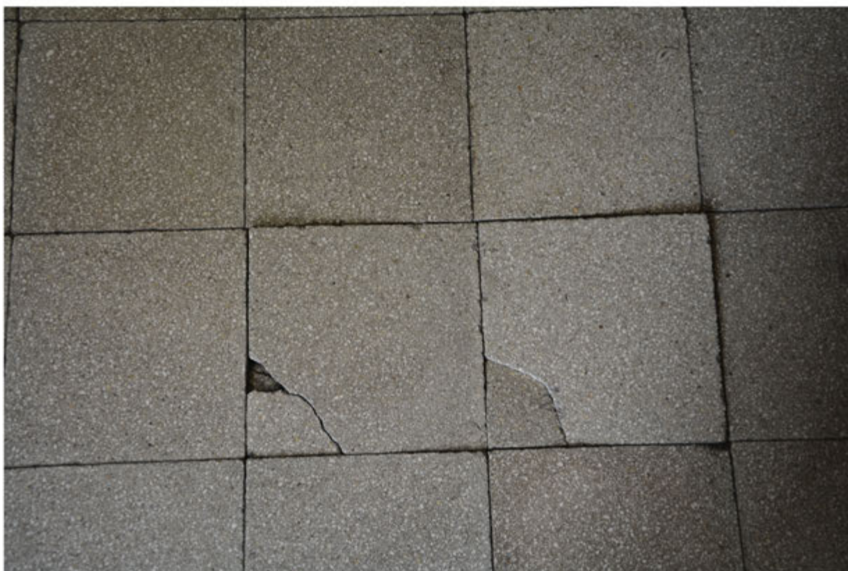
Foto 14: Unità immobiliare 1 - Dettaglio pavimento - Foglio 37 mapp.1973 sub.3
