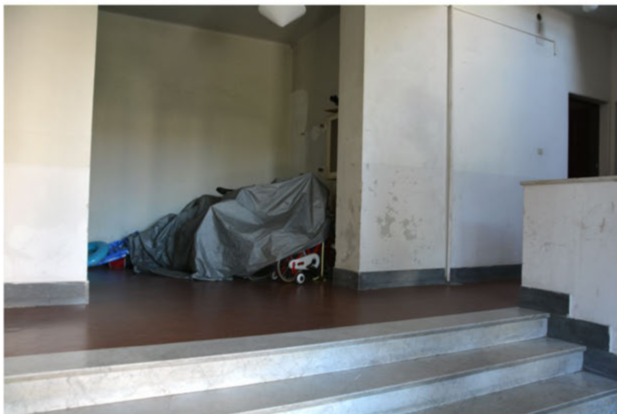
Foto 28: Unità immobiliare 3 - Rampa d'ingresso al fabbricato - Foglio 37 mapp.1973 sub.6
