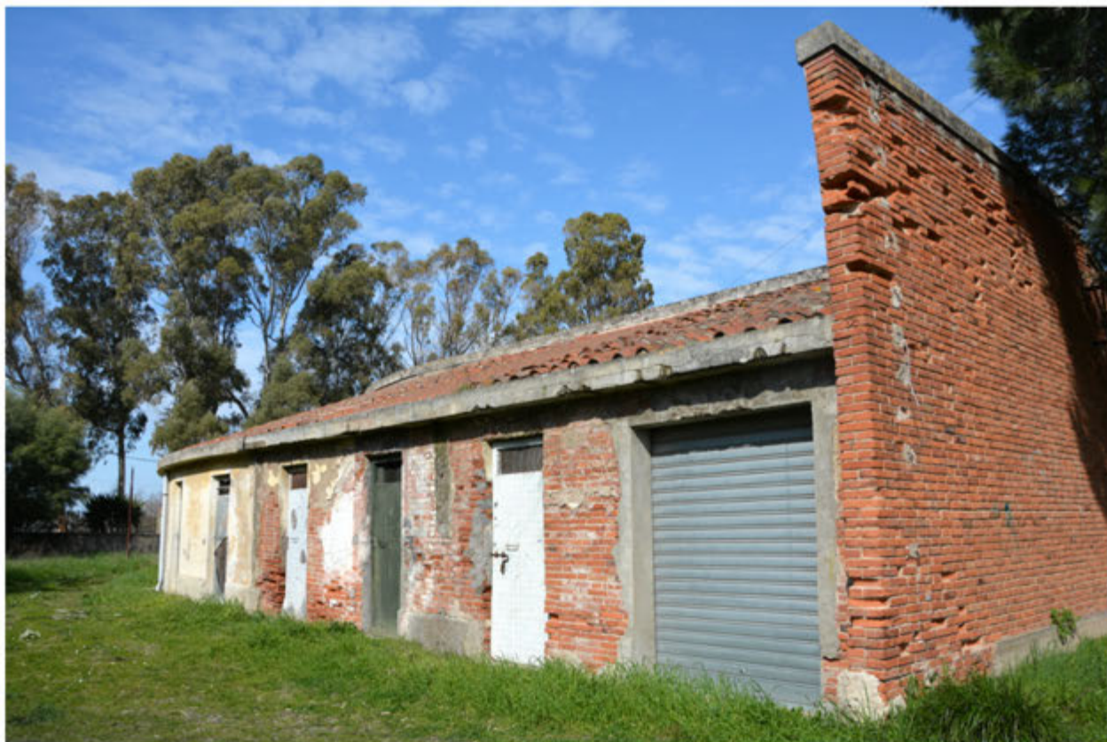
Foto 46: Unità immobiliare 7 - Vista d'insieme del fabbricato - Foglio 29 mapp.298
