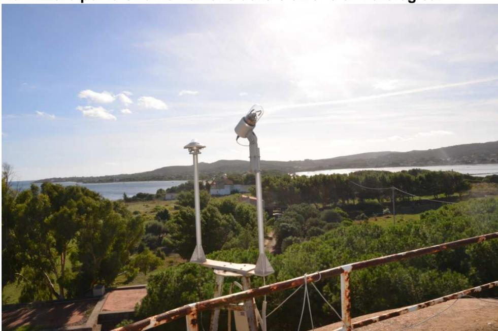
In alternativa all'utilizzo del supporto di cui alla figura A1c, l'aggiudicatario potrà proporre di installare i sensori di temperatura, umidità relativa, radiazione solare e precipitazione nelle immediate vicinanze dell'anemometro (Figura A1b), utilizzando il supporto rigido di forma cubica presente nelle immediate vicinanze dell'anemometro.
