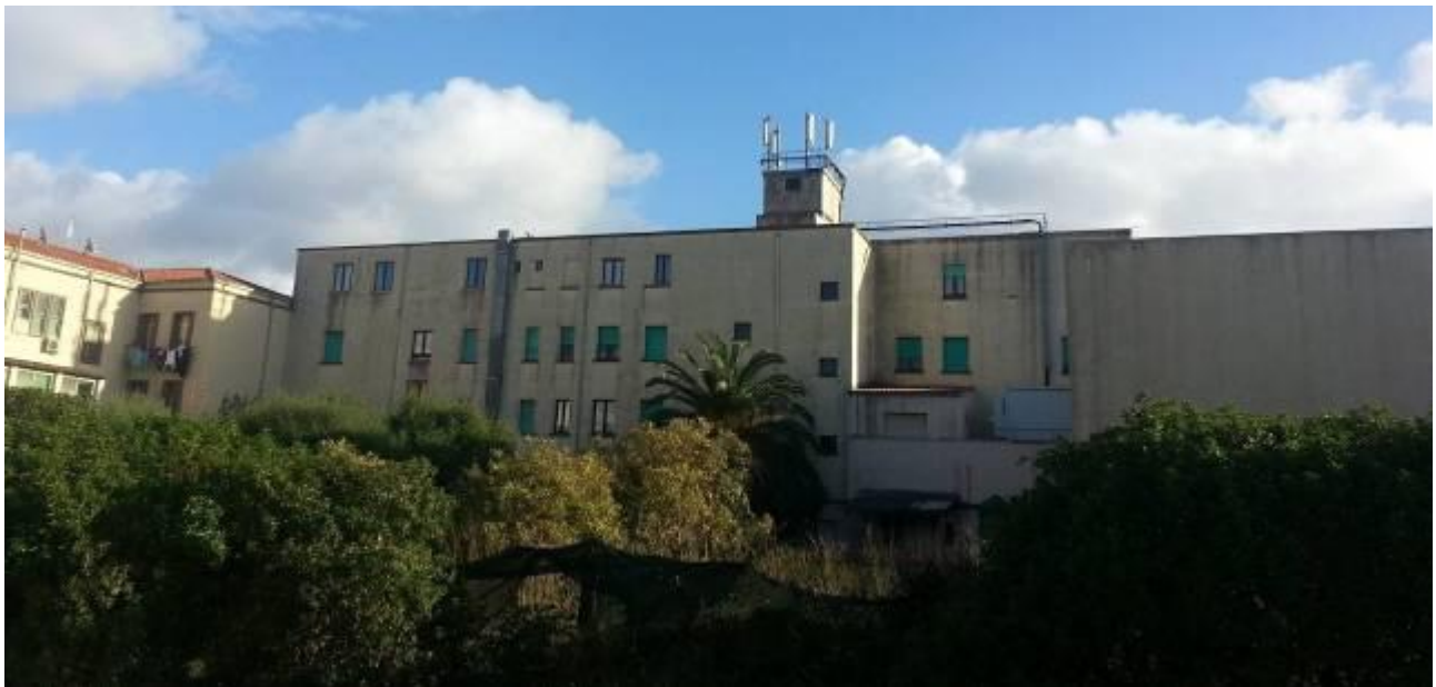
Retrospetto sul cortile interno
