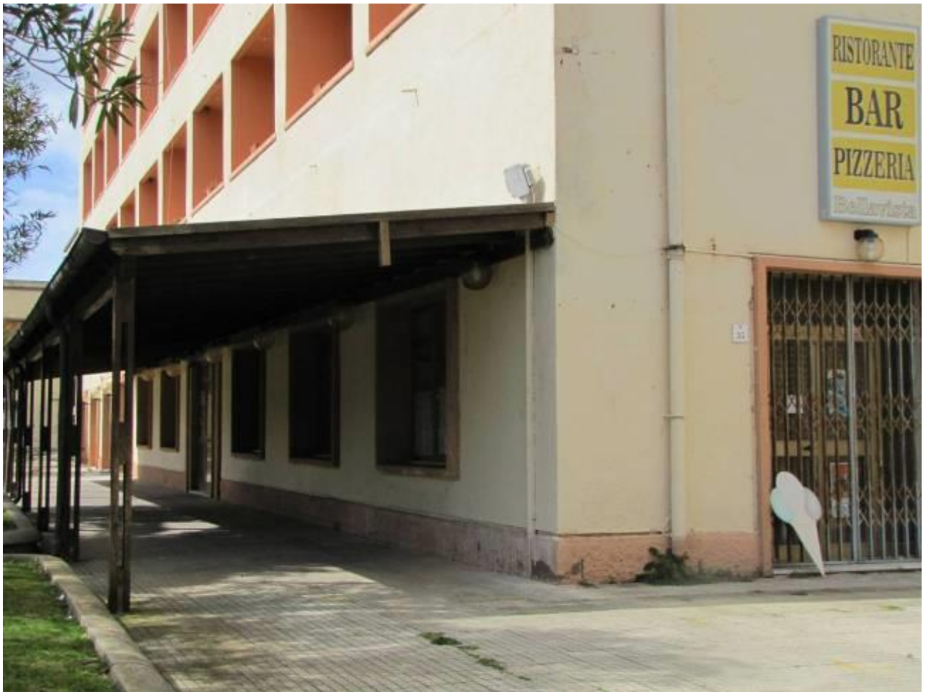
Veranda in legno abusiva sul fronte principale
