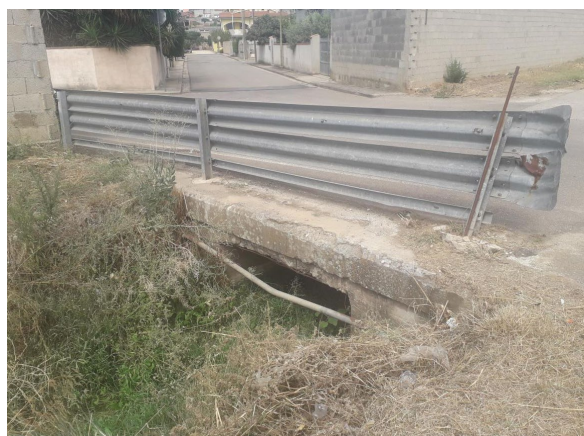
Figura 4 Canale tombato: attraversamento Via Cagliari e sbocco
