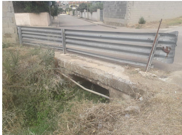
Figura 4 Canale tombato: attraversamento Via Cagliari e sbocco
