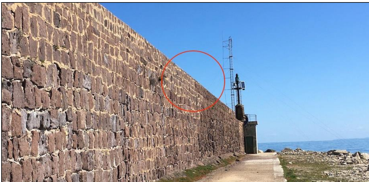
Figura 1: Punto di installazione della stazione radar HF presso il molo di ponente del porto di Porto Torres
